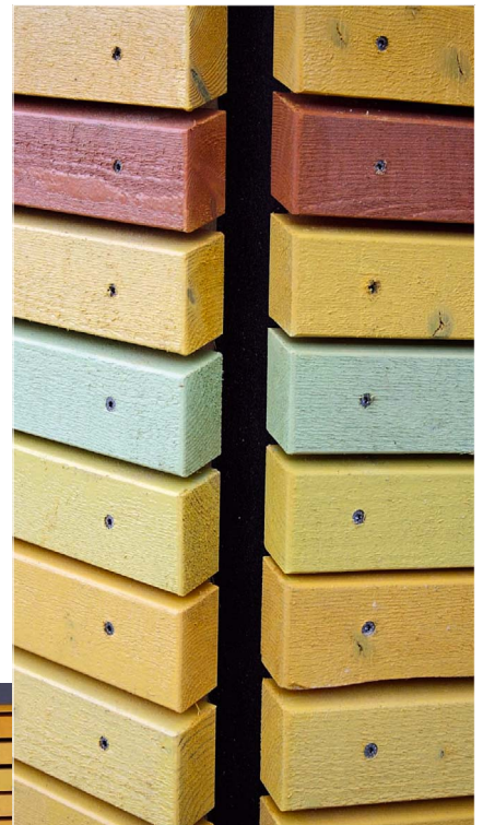
Insgesamt acht verschiedene Farbtöne geben auf der Fassade den Ton an.
